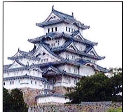
漆喰の主原料は消石灰。空気中の炭酸ガスを吸収して固まります。耐久性・耐火性に優れています。
